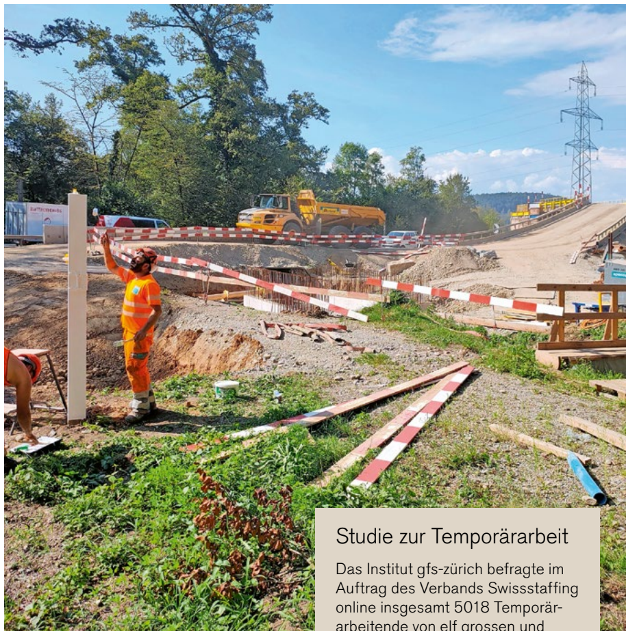
Temporärarbeit im Baugewerbe hat sich zu einem flexiblen Arbeitsmodell entwickelt.
